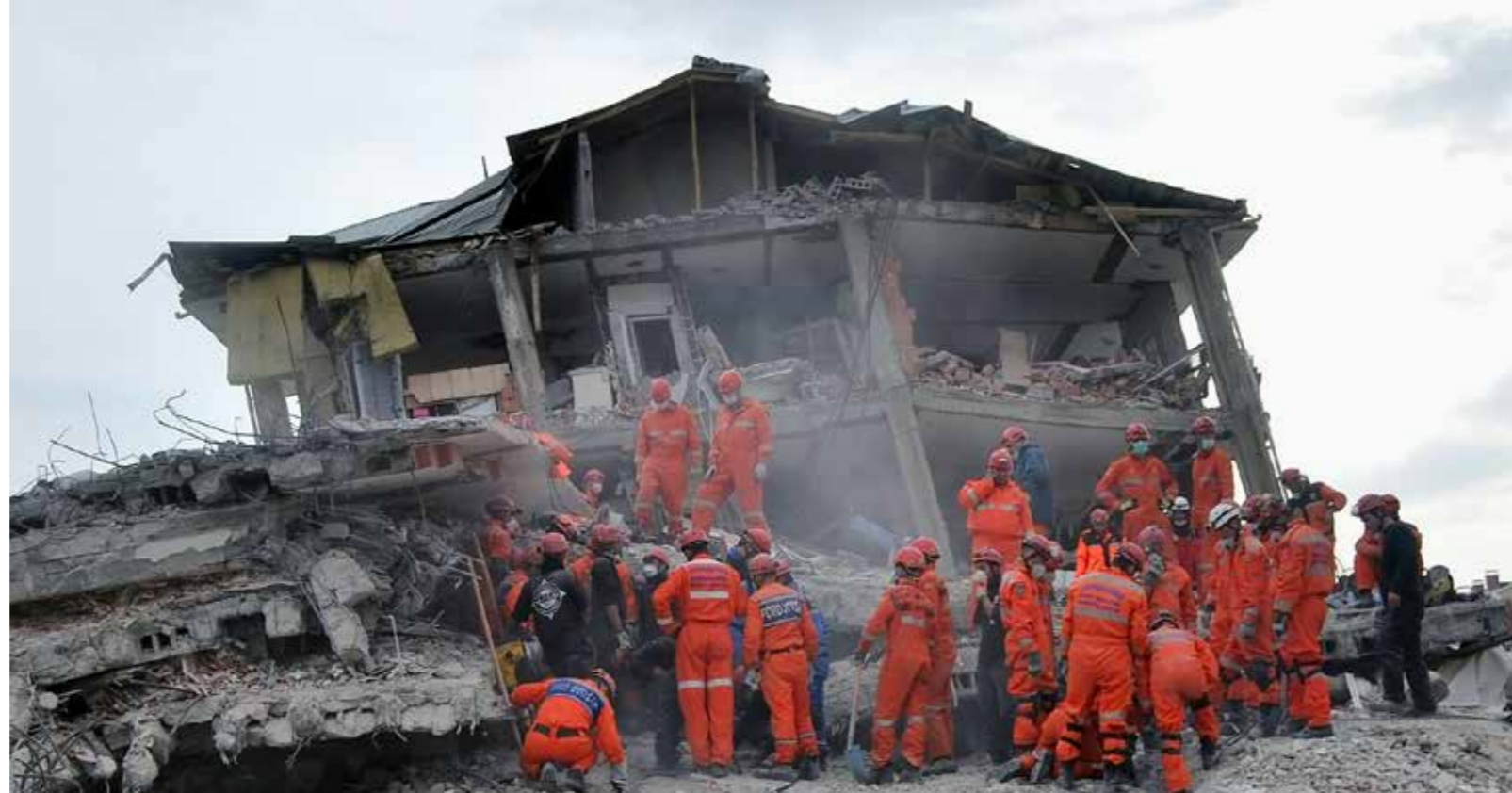
Une équipe de secours à la recherche de survivants mesure l'étendue des dégâts, après le séisme de magnitude 7.2 qui a frappé Erziş, en Turquie, en 2011, faisant perdre la vie à 600 personnes.
